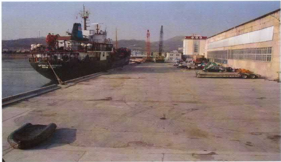
Общий вид причала ООО «СЛТ»
